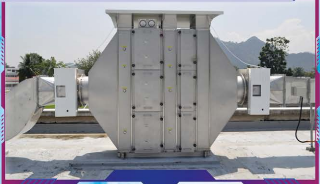
Exhaust HEPA Filter – Berfungsi untuk menapis udara tercemar dari makmal Tahap 3 sebelum dilepaskan ke persekitaran
