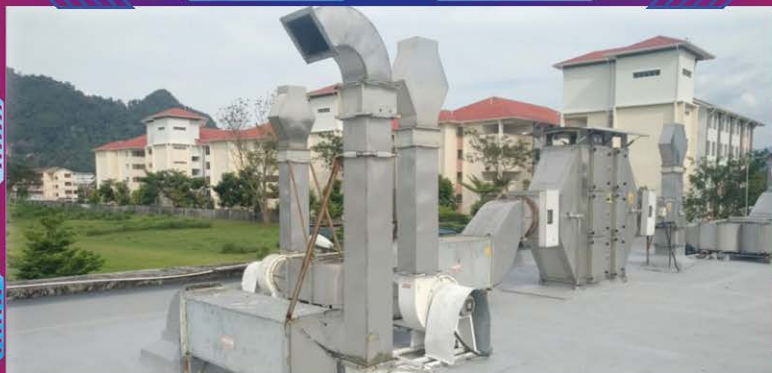
Exhaust HEPA Filter – Berfungsi untuk menapis udara tercemar dari makmal Tahap 3 sebelum dilepaskan ke persekitaran
