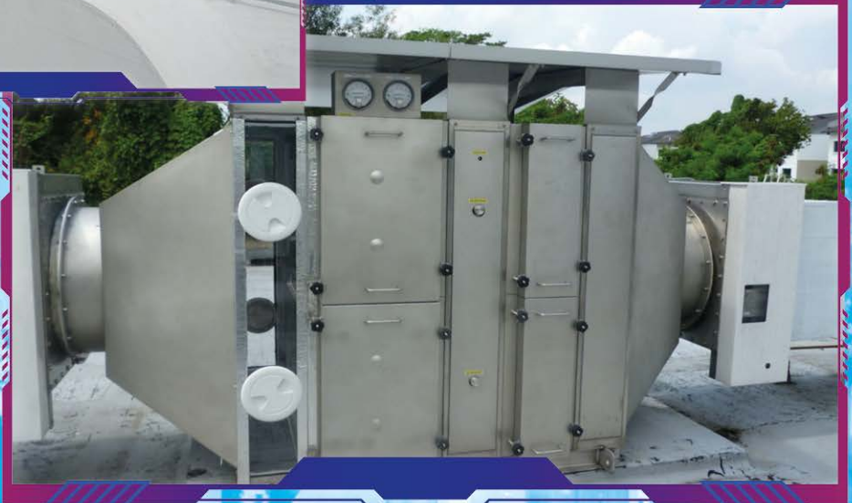
Air Supply HEPA Filter - Berfungsi untuk menapis udara yang masuk ke Bilik Eksperimen Haiwan
