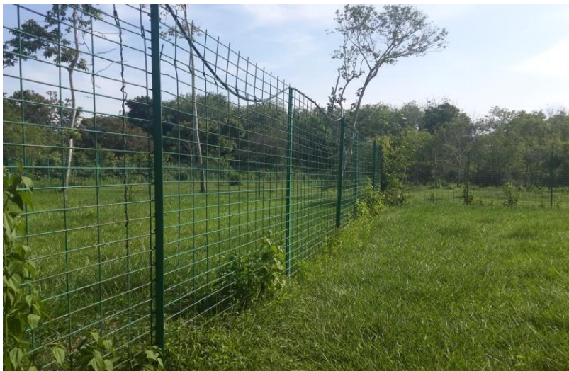
Gambar : Pembinaan kandang dengan menggunakan brc B7
