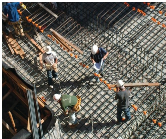
Gambar :Penggunaan brc dalam pembinaan lantai bangunan
